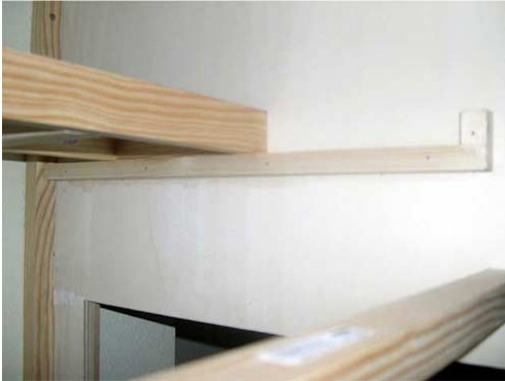
Detalle del riel que permite deslizar la luminaria.
